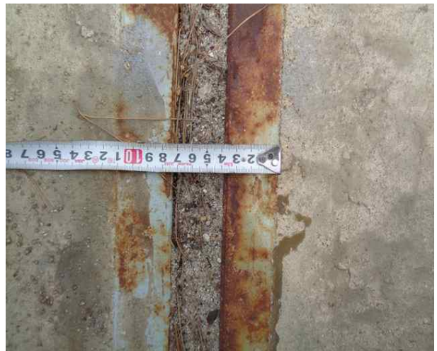
신축이음 유간 측정
