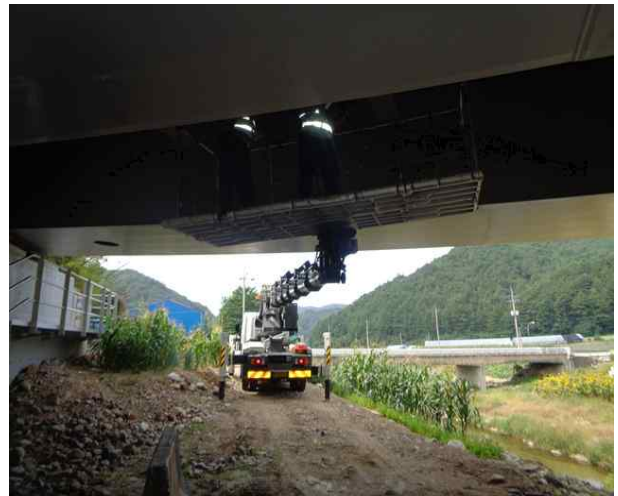
교량점검차를 이용한 근접조사
